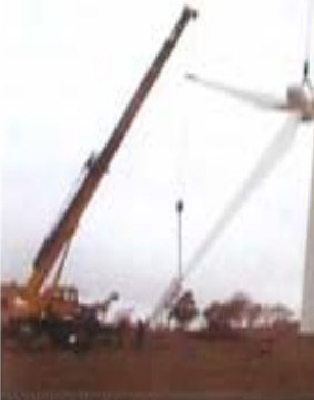
叶片吊装现场
